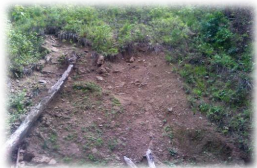
Figura 21. Derrumbe en la Quebrada La Majada.
