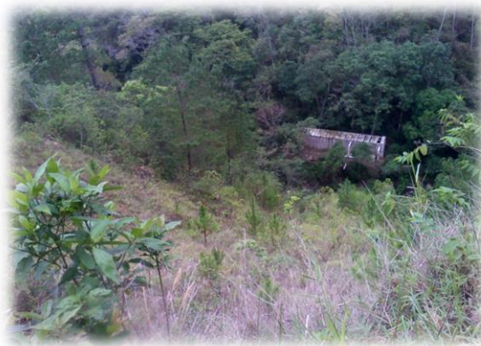
Figura 4. Vista de arriba. Regeneración del deslizamiento.
