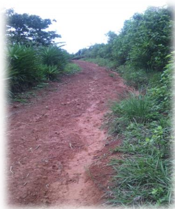
Figura 6. Deslave de terreno por escorrentía de Agua.
