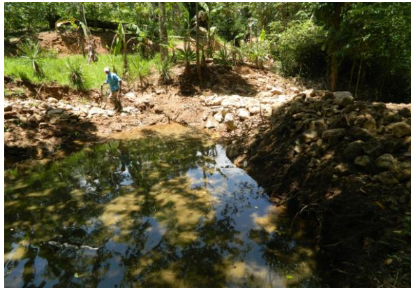
Figura 47. Daño ocasionado en el naciente de agua de la Quebrada La Jutera.
