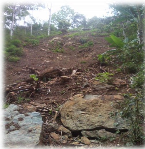
Figura 1. Derrumbe Quebrada El Matasano, Vista de abajo.
