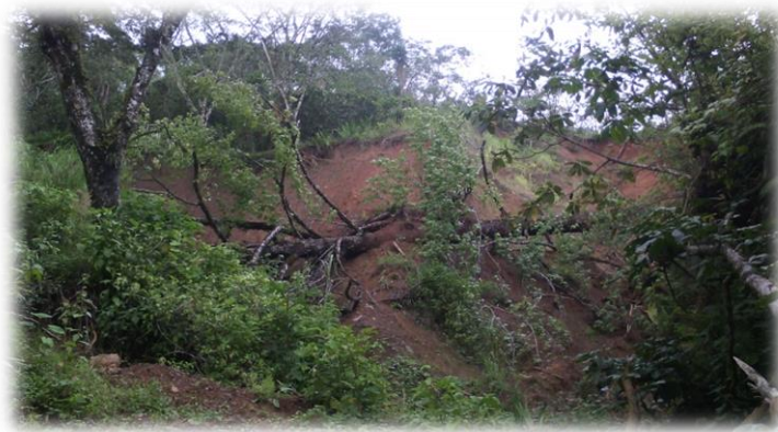
Figura 18. Derrumbe Desvío Los Planes. Enormes árboles caídos.
