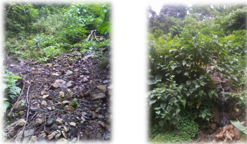
Figura 25 y 26. Deslizamiento en la Represa de La Jaguita.
